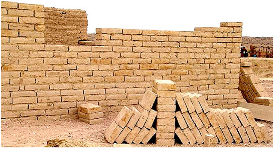
Fig. 7 Construcción con adobes en Ojinaga, Chihuahua
