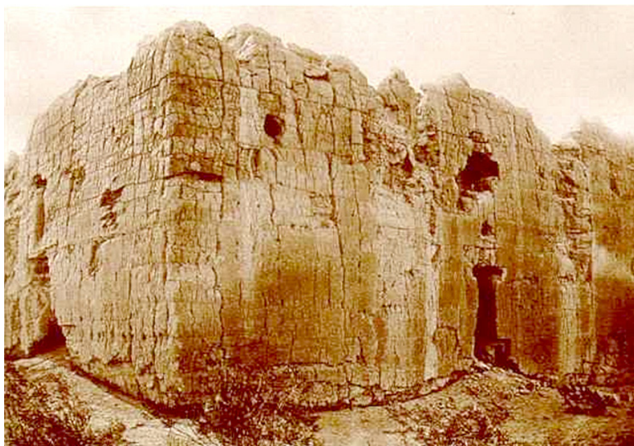
Fig. 5. Ruinas de la Casa Grande en Arizona Autor desconocido. ca 1900
